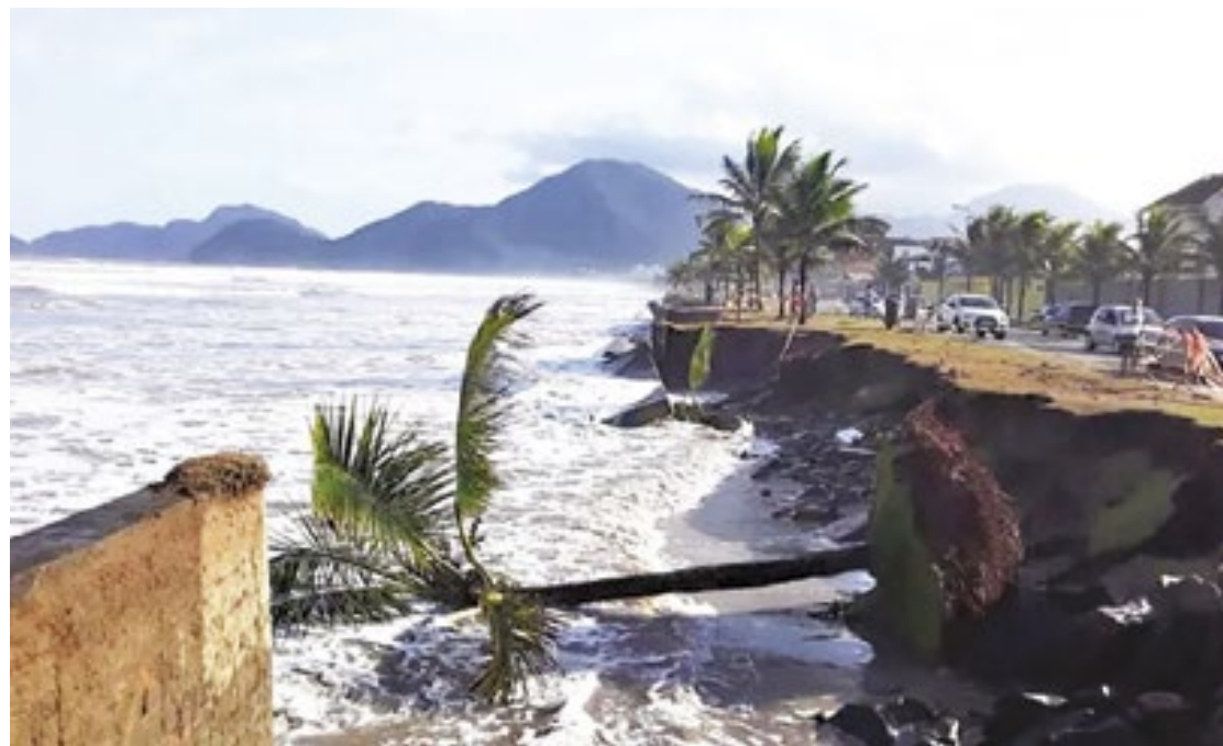
Uma forte ressaca destruiu parte da orla de Peruíbe, danificando a mureta e a avenida em 2020
