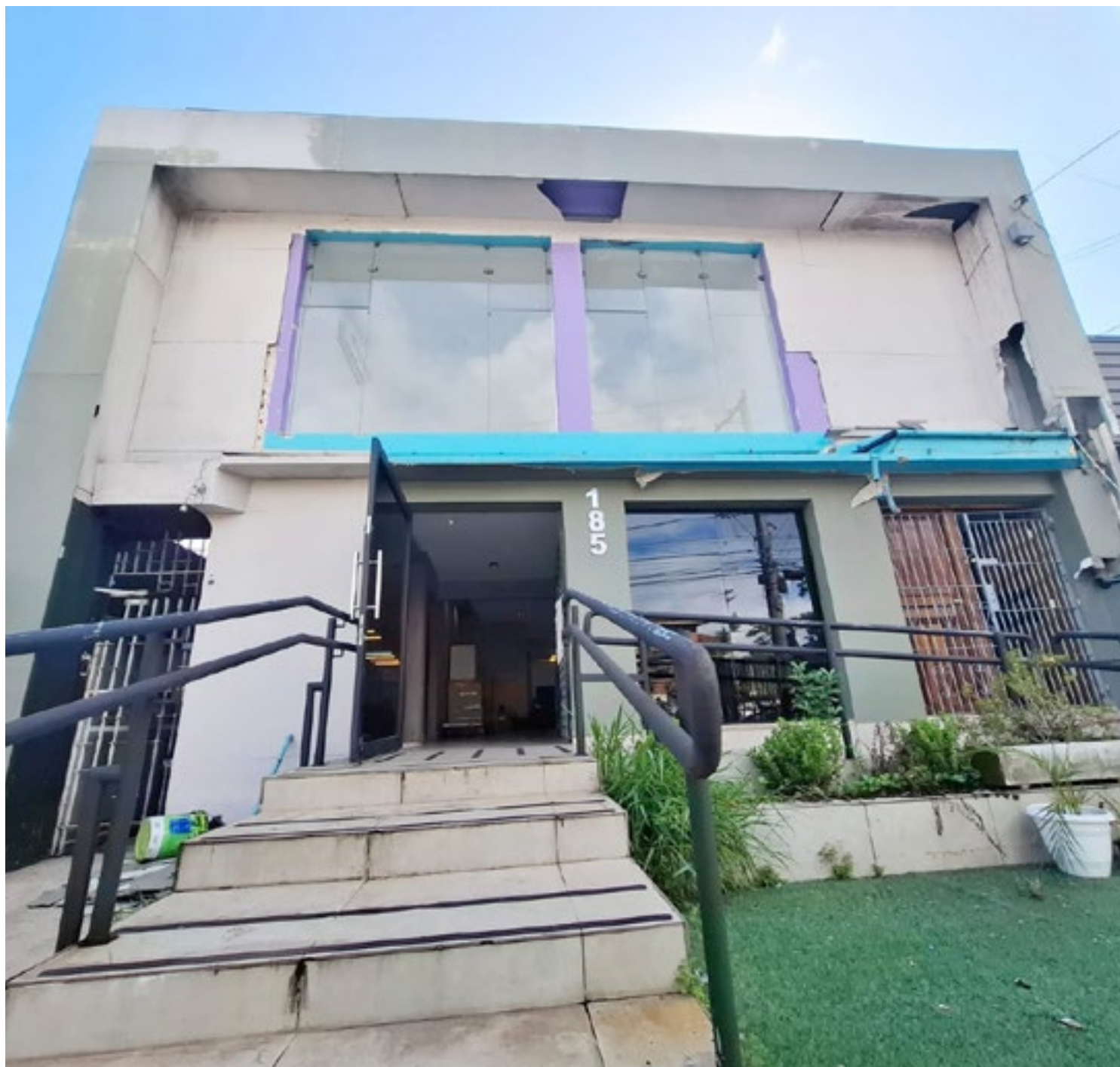
Prédio se encontra até hoje em obras e nunca foi usado para atendimento ao qual se propôs. A culpa do atraso recai sobre furtos
