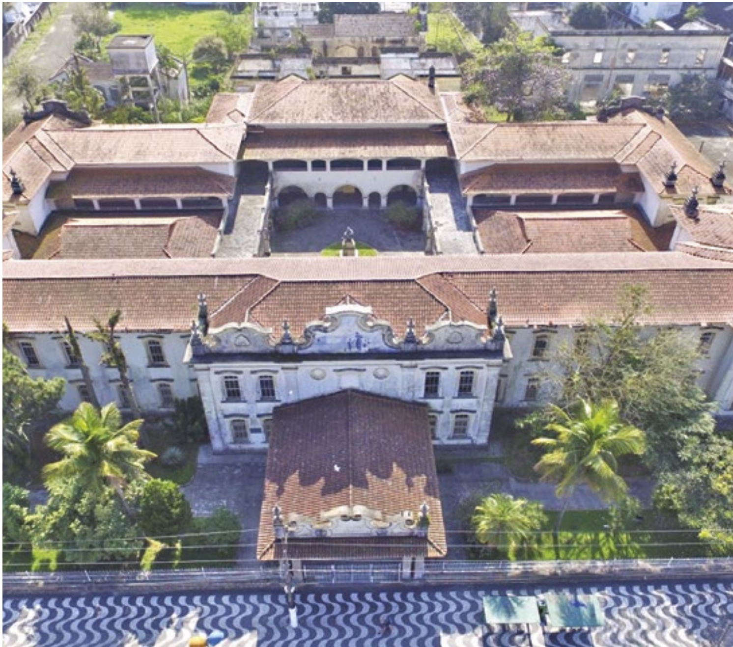
Orçado inicialmente em R$ 50 milhões, projeto de recuperação das características originais custaria, hoje, R$ 77 milhões
