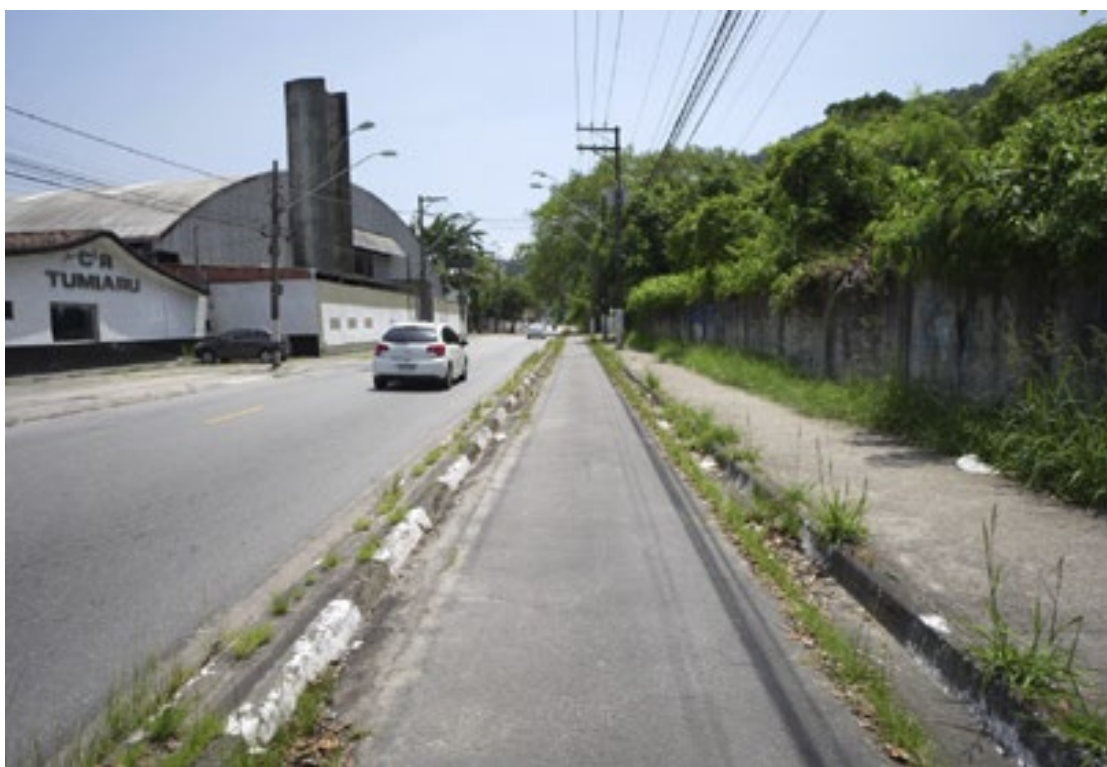
Obras, prestes a serem iniciadas, contemplarão troca do piso, drenagem e sinalização
