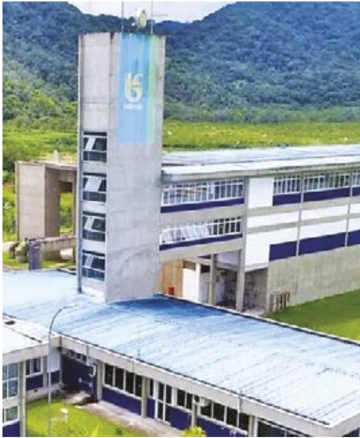
Montante será utilizado para expandir e melhorar a rede de distribuição de água, além da coleta e tratamento de esgoto
