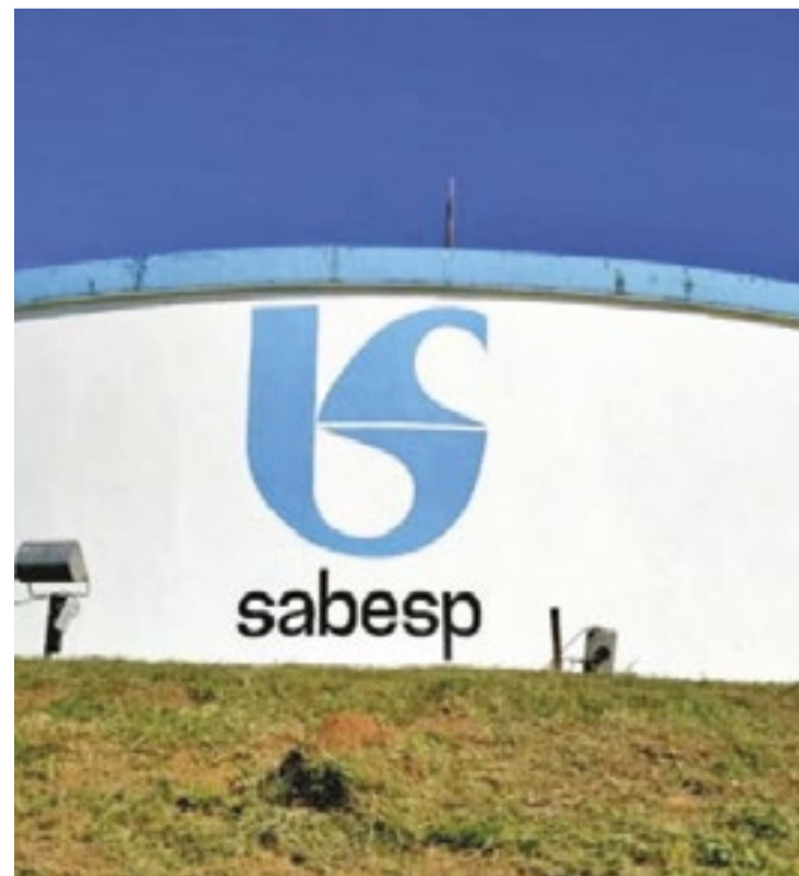
Ainda em 2025, 40 mil residências da região passarão a ter conexões de água e esgoto em meio plano de universalização
